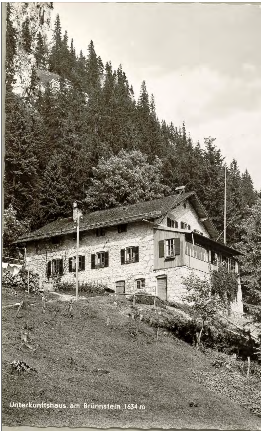
Das Brunnsteinhaus vor den Anbau- und Umbaumaßnahmen
